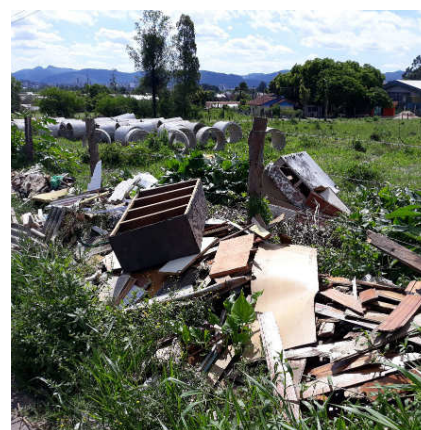
Disposição irregular de resíduos de construção na faixa de domínio na ERS-239
