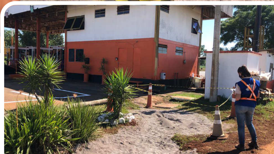
Avaliação do novo sistema de tratamento de efluentes na praça de pedágio de Coxilha
