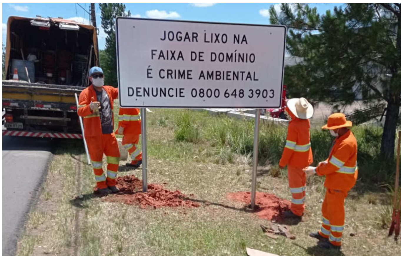
Instalação de novas placas ambientais
