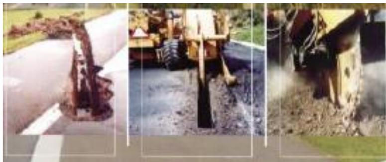
Figura 5– Dreno Sub-superficial de pavimento
