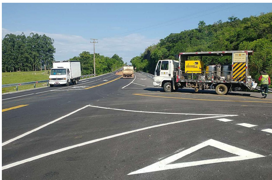
Supervisão ambiental acompanha a execução dos serviços de manutenção rodoviária
