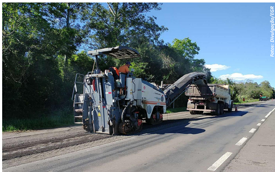
Serviço de fresa é realizado na RSC-453, em Teutônia
