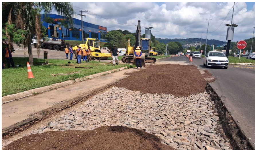
Equipes executam reparo profundo na ERS-239, em Novo Hamburgo, e na ERS-235, em Nova Petrópolis
